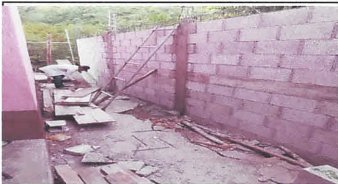
Levantado de muro perimetral.
