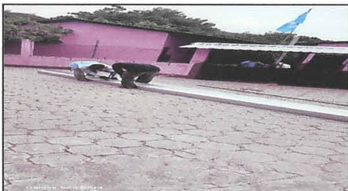
Construcción de Galera.
